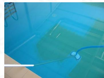
Действие пылесоса происходит с помощью вакуумного наконечника, который подключается к скиммеру или к соплу возврата воды (инлэт). К вакуумной насадке прикрепляется телескопическая ручка и один
